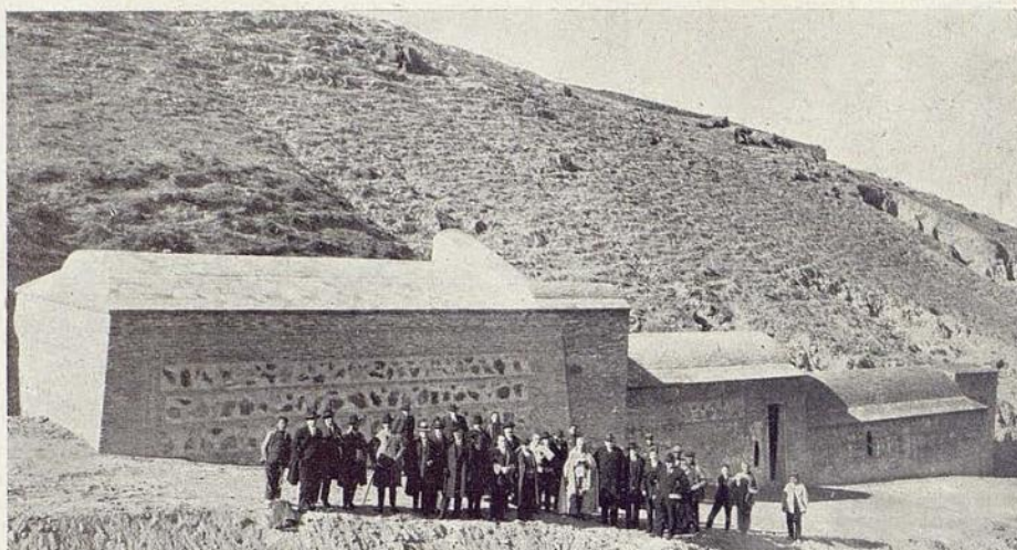
LAS AUTORIDADES MUNICIPALES EN EL ACTO DE SER BENDECIDO EL NUEVO DEPÓSITO PARA AGUAS DE CABRAHIGOS
