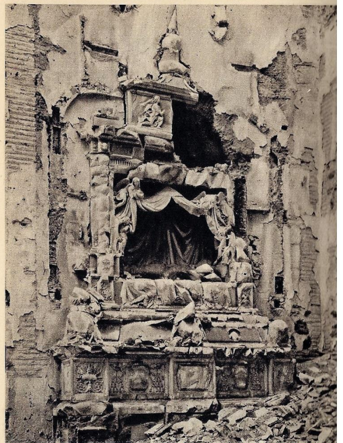
Toledo. San Juan de la Penitencia. Sepulcro en mármol blanco, del Cardenal Fundador destruído por el fuego, habiendo quedado los muros en forma que amenazan derruirse.
